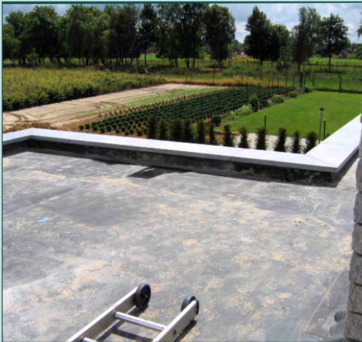
A FINISHED EPDM ROOF PHOTO: WIKIMEDIA COMMONS : KVDP
